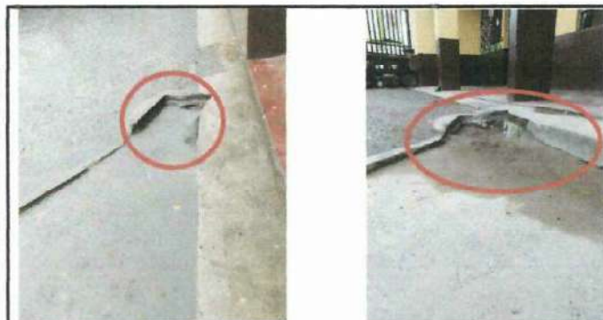
FOTO 5: Este es el único drenaje que se encuentra dentro de la escuela para desfogue del agua por las lluvias pero no se da abasto y por ello se inunda el area del patio cuando llueve.
