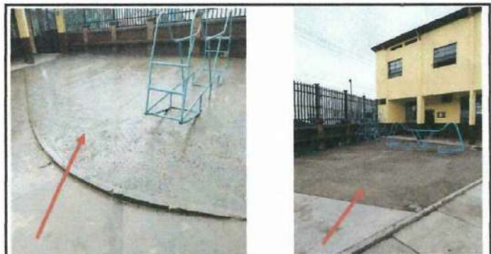
FOTO 6: El entortado que se encuentra en el patio en donde están ubicados los juegos no está adecuado para los niños ya que se encuentra el pedrín levantado y a sido motivo de varios golpes.
